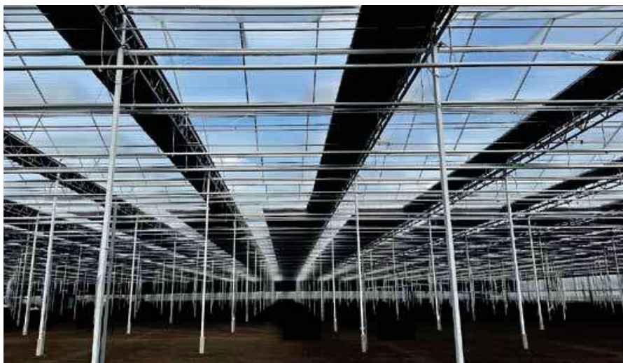
Een primeur binnen de chrysantensector: een verduisteringsscherm, een zonnenscherm én een energiescherm.
