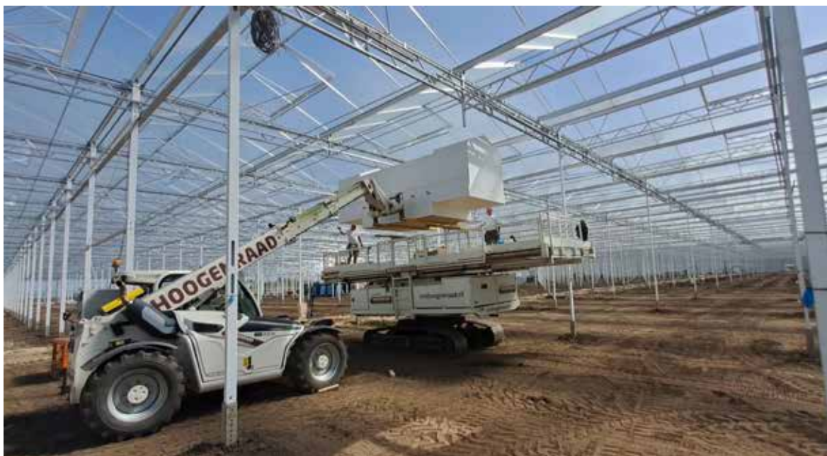
De LBK's die boven het middenpad hangen bij Middelburg Chrysanten, winnen de benodigde latente warmte voor het ontvochtigen terug via lucht/water-warmtewisselaars.
